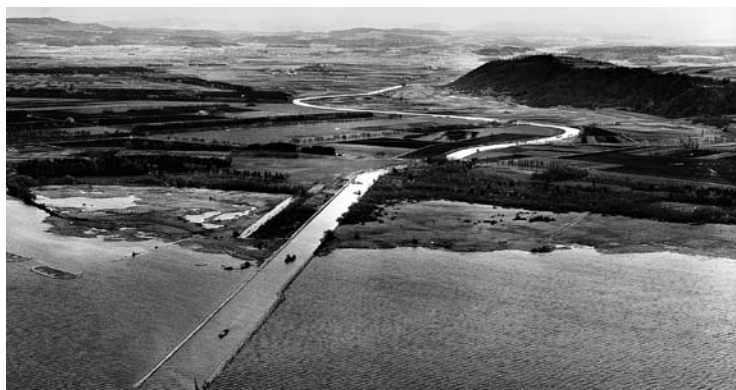
Die Zweite Juragewässerkorrektion nimmt Gestalt an: Arbeiten bei der Mündung des Broyekanal in den Neuenburgersee bei La Sauge. Rechts oben im Bild ist der Mont Vully gut erkennbar. (archiv susanne müller)
